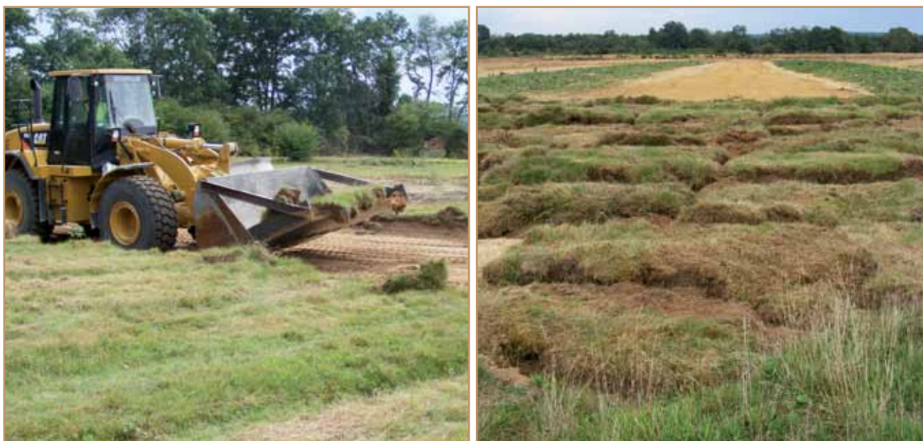
Figure 40 Travaux de déplaquage
