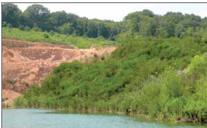
Figure 91 Genêt à balais sur front totalement remblayé
