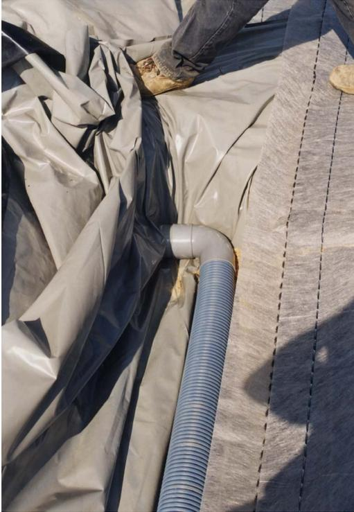
**La mise en place du drain dans la tranchée latérale**
