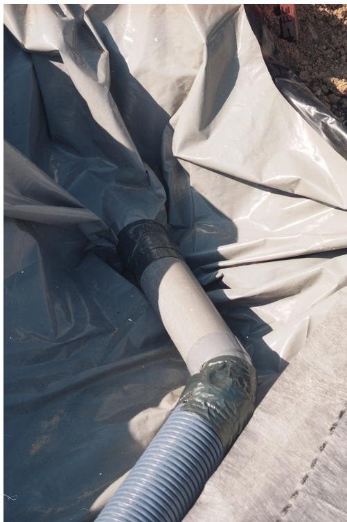
**Les drains sont placés dans la membrane étanche et donc isolés des terrains extérieurs**
