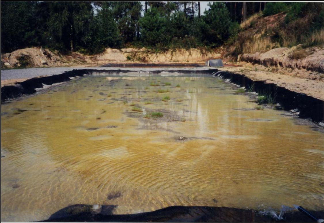
**Photo IV. 6: Bassin de traitement fin août 2000, après la mise en place des graviers supérieurs.**
