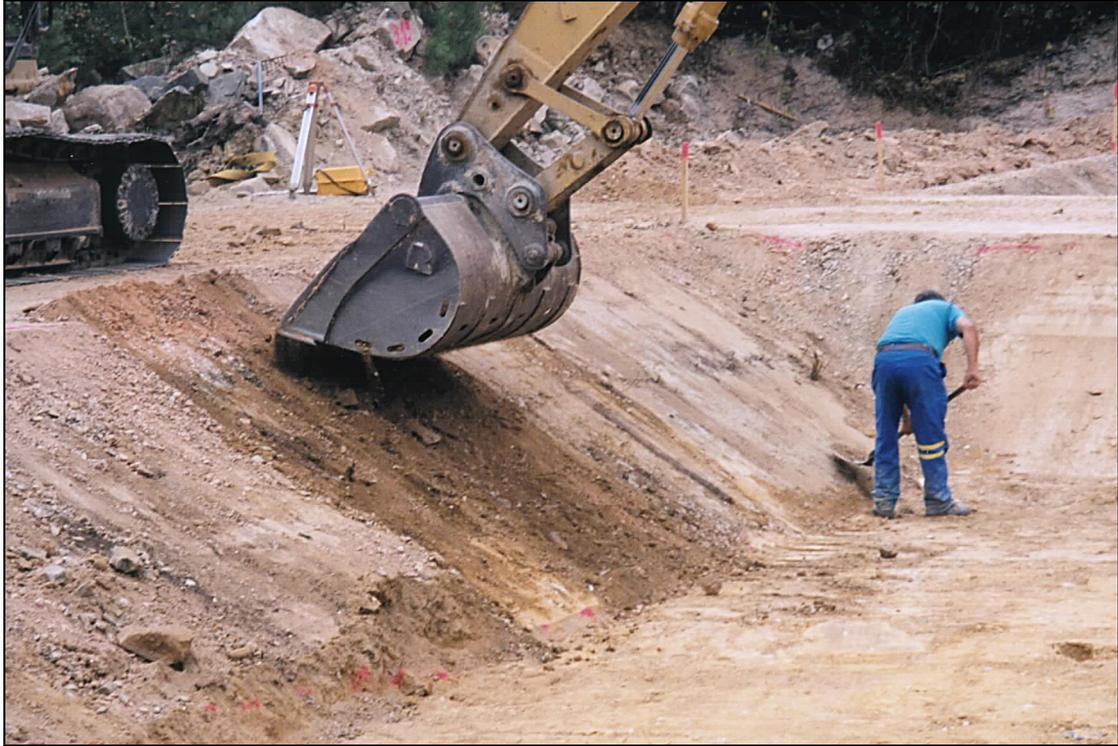
**Photo IV. 1: 2 sept.99 : Talutage des bassins avec une pente de 3/2**
