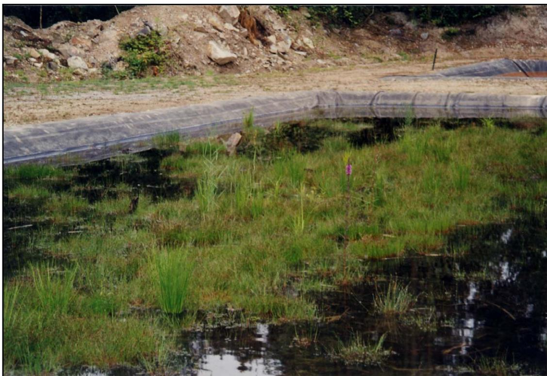
Photo IV. 5: Juillet 2000 : Végétation pionnière du bassin de traitement, avant mise en place de la couche supérieure de graviers.
