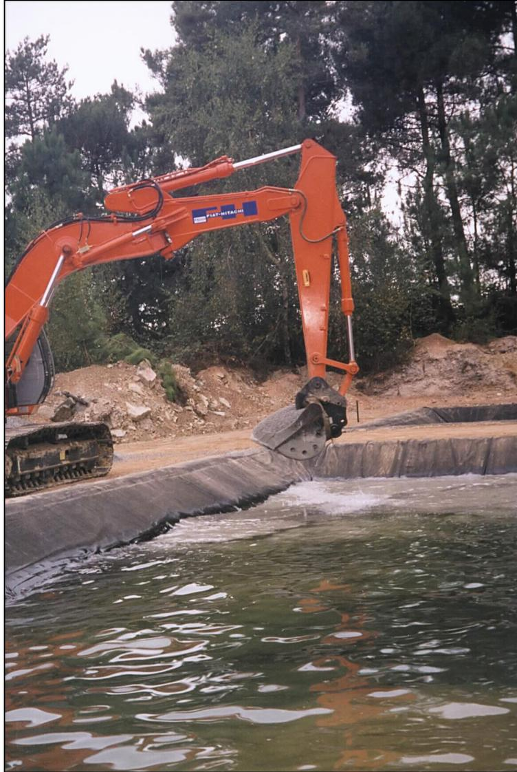
**Photo IV. 2: 15 sept.99 : Mise en place des graviers calcaires dans le bassin en eau**
