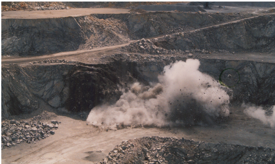
Fig. 13 : Abattage du front de taille à l'explosif.
