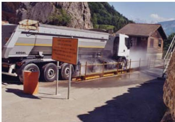
**Lavage sous pression des roues et châssis**
