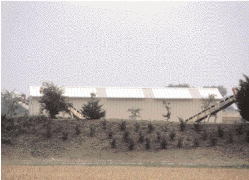
Bâtiment permettant une certaine réduction du bruit, bien que non prévu initialement pour cela. Les sorties des bandes transporteuses, ainsi que les passages éventuels de matériels mobiles sont protégées par un merlon (1)
