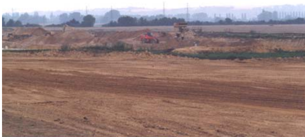
Travaux d'extraction Site de la Grande Paroisse
