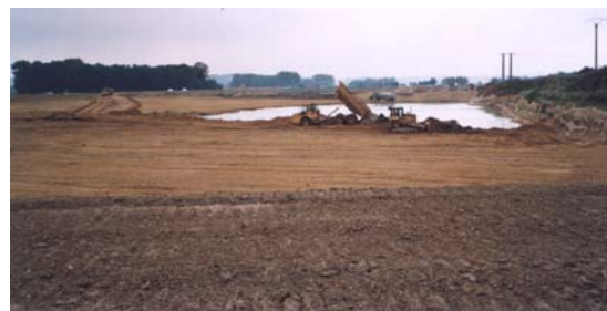
Travaux de réaménagement
