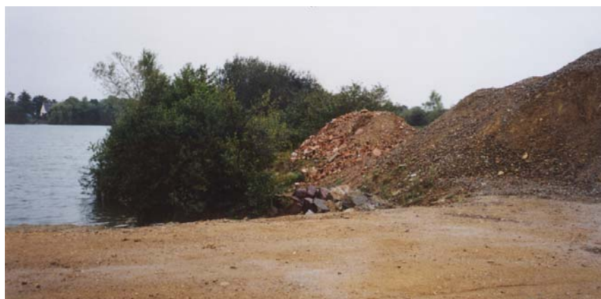
Dépôt de matériaux en bordure du plan d'eau de la Piblaye
