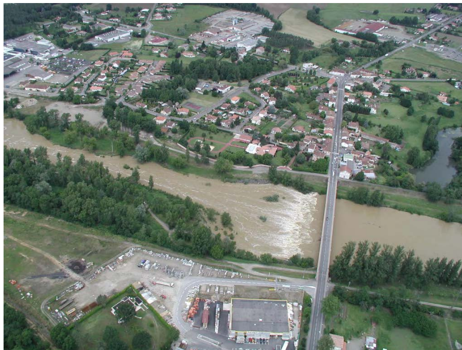
Le pont de Saint Sever et son seuil de protection
