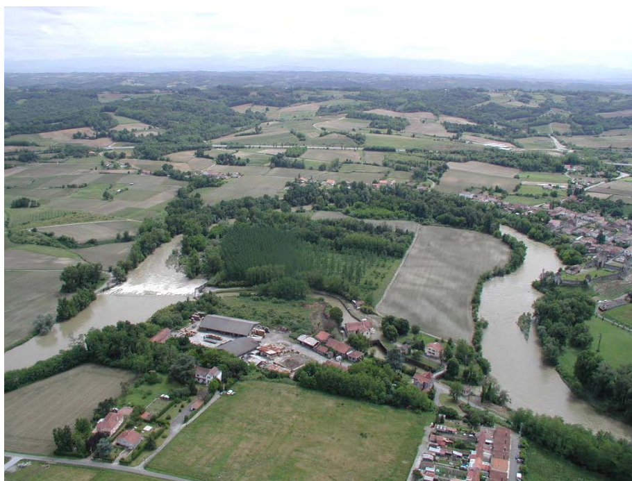
Le seuil de la centrale de Puyoo
