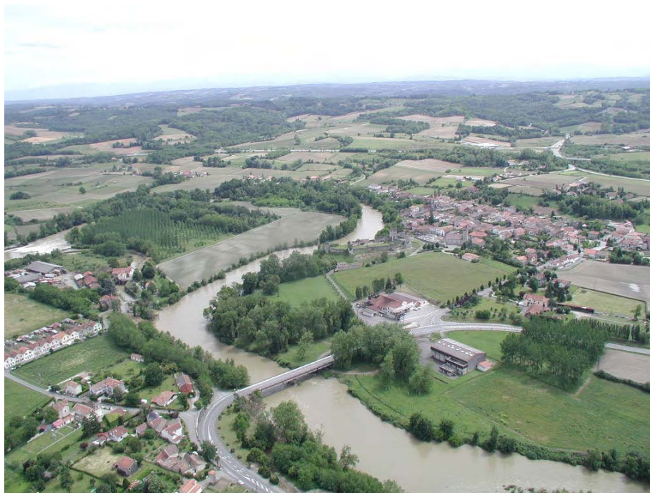
Le pont de Puyoo-Bellocq
