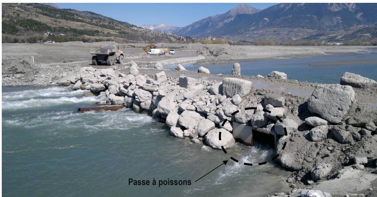
Depuis 2012, Routière du Midi optimise le passage busé permettant aux engins de chantier d'accéder aux zones d'extraction de matériaux situées en queue de retenue du barrage de Serre-Ponçon. Pour cela, le passage busé est équipé d'une passe à poissons mise en œuvre à partir d'une benne de semi-remorque recyclée.
