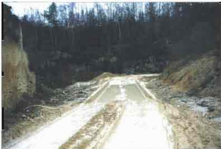
Un accès imperméabilisé mais non entretenu
